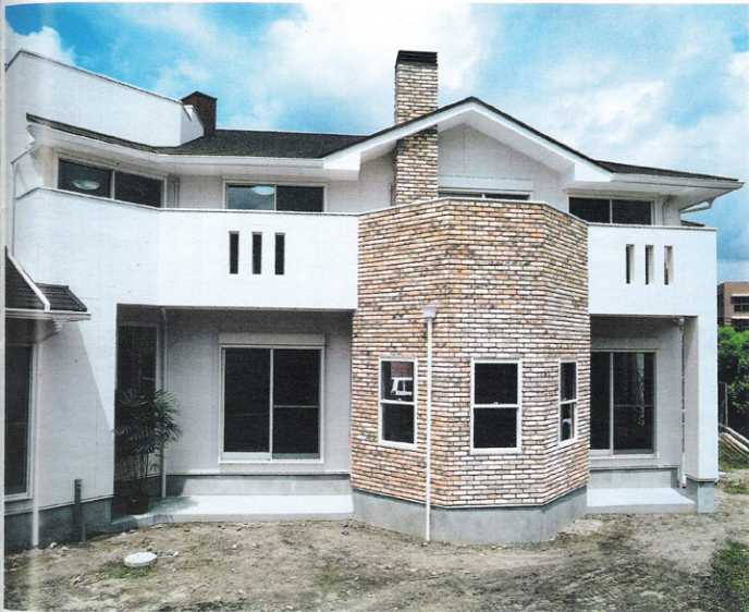
【外観】中庭より見た建坪70坪の壁々としたM邸。白い壁面と茶色の複瓦屋根タイルが美しいコントラスト。
